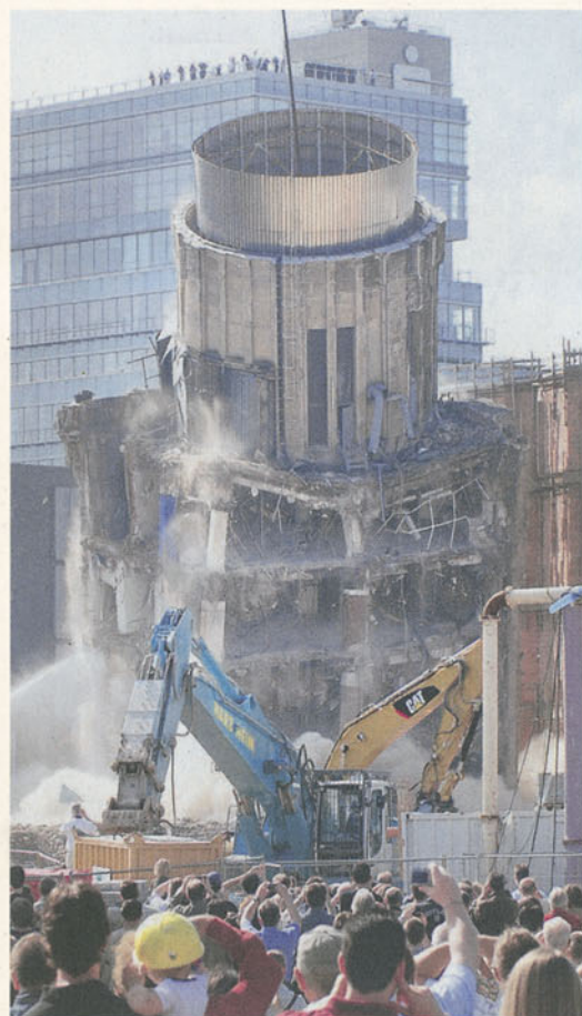
Ohne Probleme und völlig planmäßig wurde Ende Mai der rund 35 Meter hohe Turm des ehemaligen Karstadt-Kaufhauses auf dem Gelände des neuen Einkaufszentrums Limbecker Platz gesprengt. Mehr als 1000 Zuschauer am Rande des Geschehens applaudierten am Ende für die „Punktlandung“. Teilweise waren die Schaulustigen schon am frühen Morgen an-
