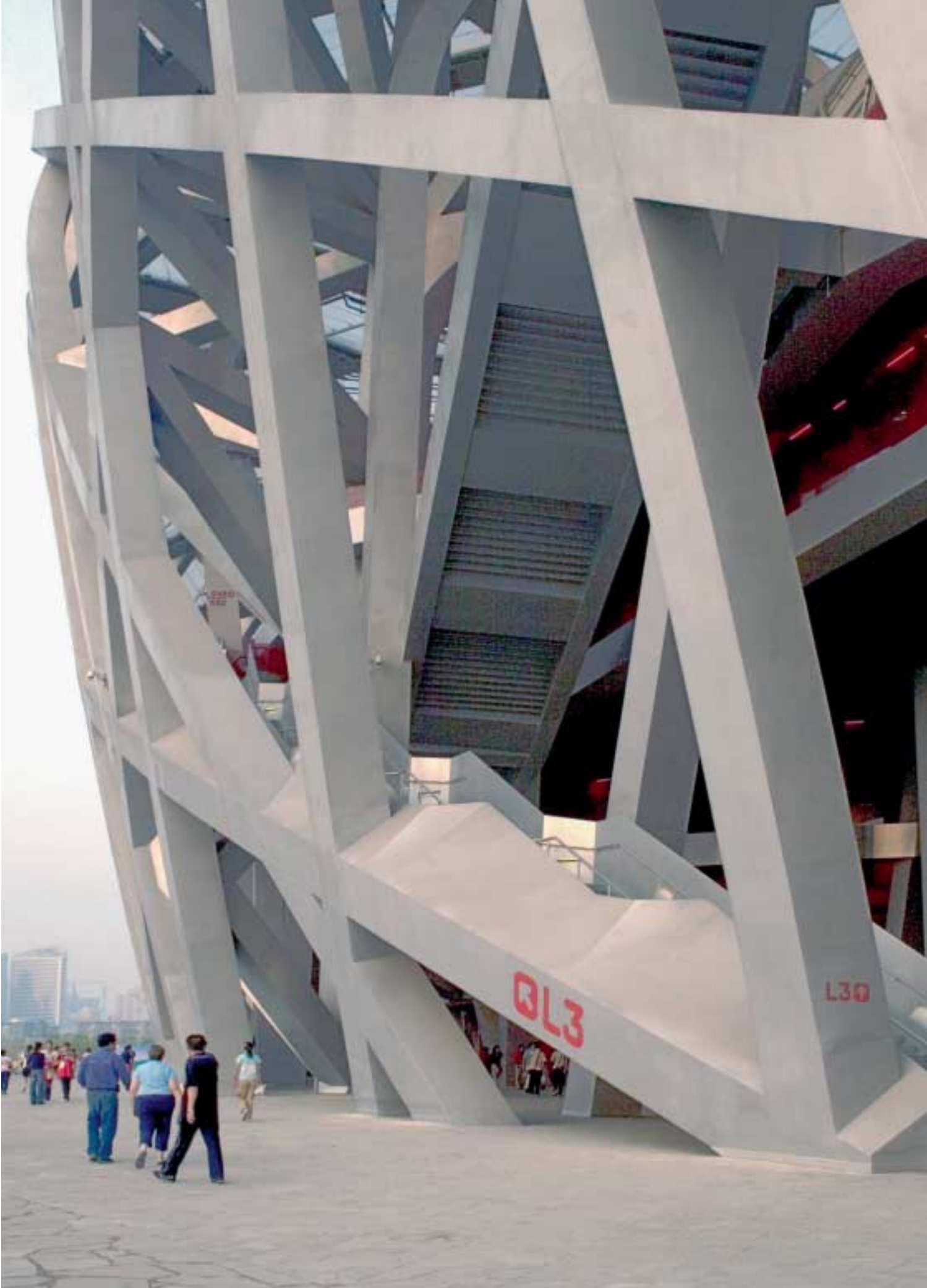
Abb. 2: Zwischen den Stahlstreben der monumentalen Außenhülle kann man die Treppen und Tribünen aus Betonfertigteilen erkennen
